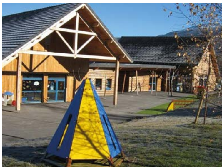
LA MAISON DES OURS À VILLARD-DE-LANS
