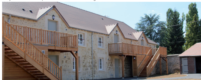
Sacy-le-Petit : un corps de ferme réhabilité en logements sociaux.
