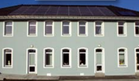
La mairie de Tournon avant et après réhabilitation
