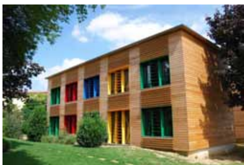
Un bâtiment rénové de l'école du Grégoire Source : Ville de Dardilly
