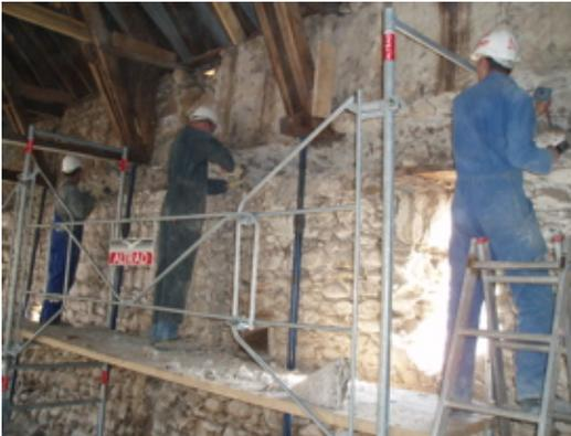
Consolidation des murs par galets au mortier de chaux
