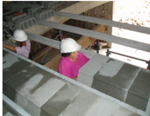
Détail de la pose de plancher hourdis
