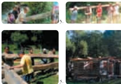
L'attente à l'abandon depuis plusieurs années, de nombreuses poutres étaient en mauvais état et d'autres inutilisables. Il sera nécessaire de réduire la taille du nouveau bâtiment et produire de nouvelles poutres. Les nouvelles poutres seront réalisées sur place.
