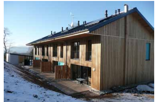
Une opération de logements sociaux locatifs accolés, HQE®, en bois et économes en énergie à Combrimont.
