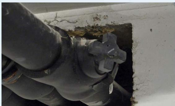
Exemple de conduit de soufflage isolé équipé d'une vanne d'équilibrage.
