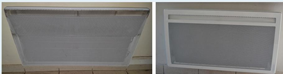
Ancien convecteur électrique (à gauche) remplacé par un convecteur électrique plus récent (à droite) piloté par une centrale de programmation multizones.
