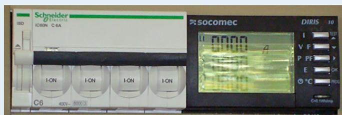
Compteur d'énergie électrique sur quatre départs de convecteurs électriques.
