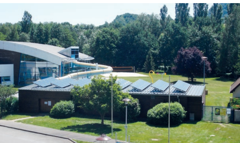
CENTRE NAUTIQUE : PANNEAUX SOLAIRES HYBRIDES
