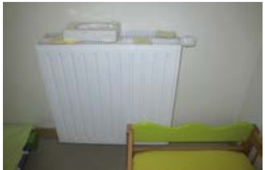
Mauvaises pratiques observées : « obturation » des équipements techniques
