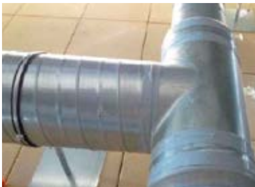
Etanchéité à l'air des réseaux aérauliques
