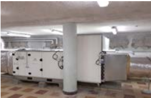
Groupe scolaire à Echirrolles – ACOBAT Architectes
