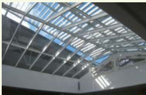
Brise-soleil au niveau de la verrière du bâtiment de l'espace BTP à Valence - SOHRA
