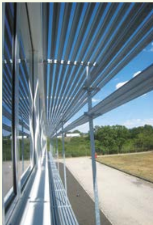
Brise-soleil horizontal, bâtiment de ZF Bouthéon à Andrézieux-Bouthéon - DURNERIN-CO
