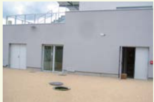
Accès Nourice Installation géothermie sur sondes
