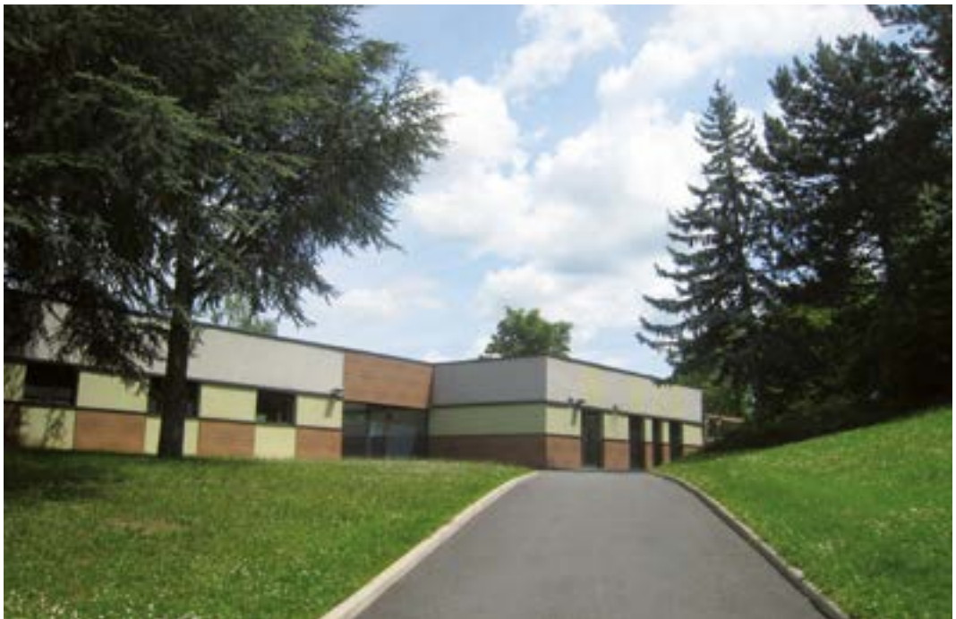
Présence naturelle de masques grâce à la végétation environnante de la structure multi-accueil petite enfance à Saint-Chamond – Atelier d'Architecture RIVAT
