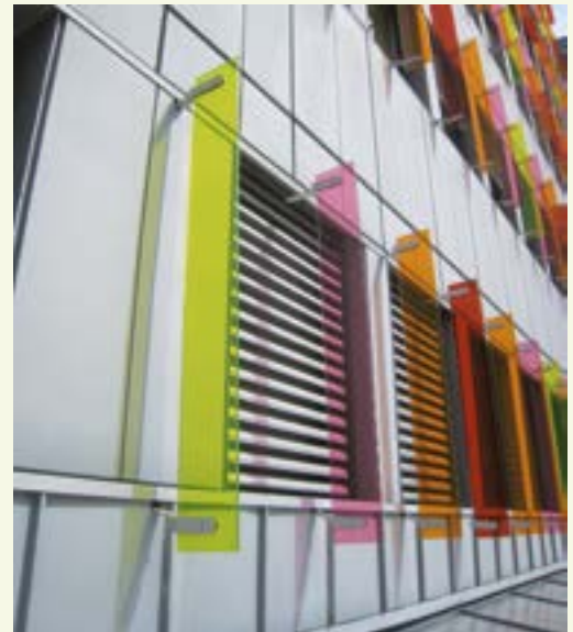
Ventelles verticales fixées sur les façades Est et Ouest du bâtiment de la CAF 74 à Annecy - DE JONG Architectes
