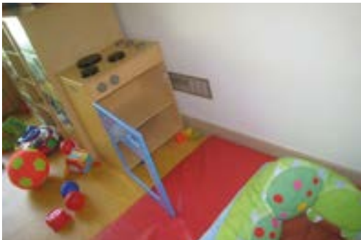
Mauvaises pratiques observées : « obturation » des équipements techniques
