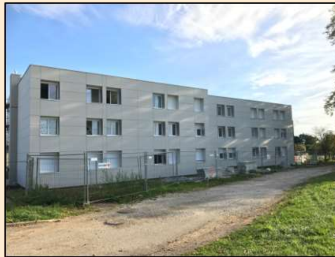
Après Opération C
