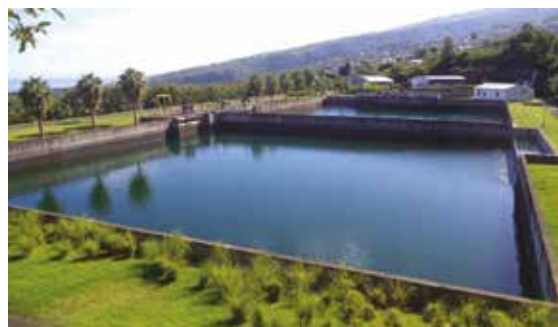
Le Réservoir de Mont-Repos à Saint Paul (La Réunion) de la Saphir
