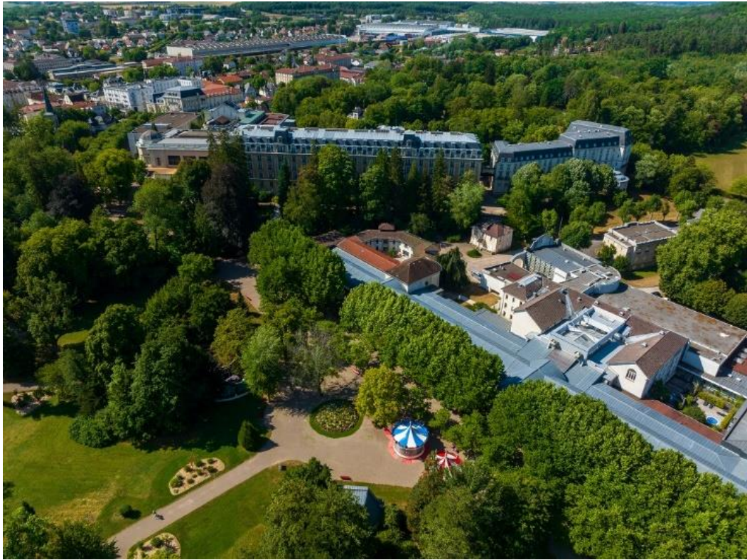
Vue d'ensemble de la station thermique de Vittel ©Drone Vosges
