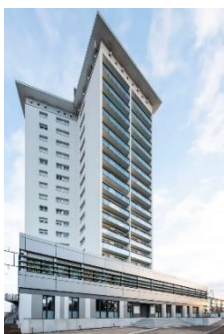
Tour Schwab, MSP au rez-de-chaussée
