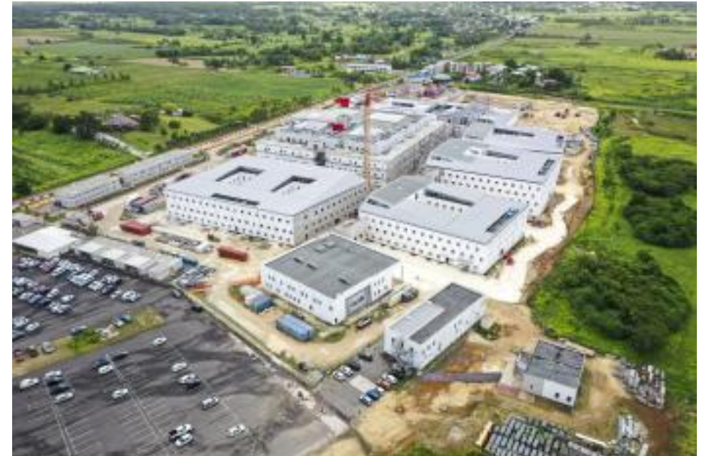
Chantier du futur CHU de Point-à-Pitre © SEMSAMAR
