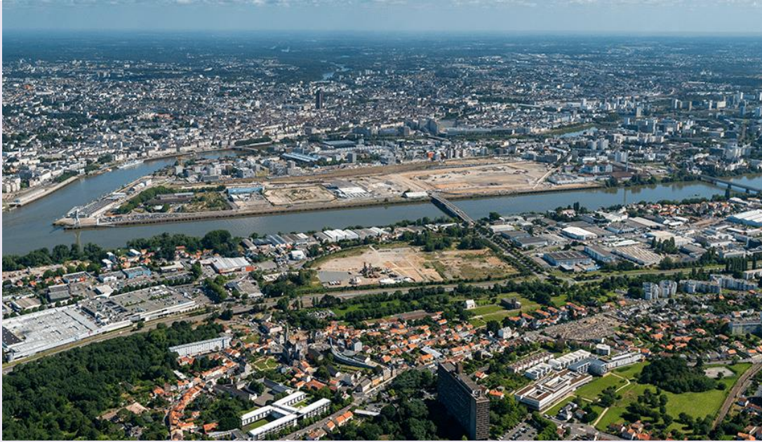
Le Secteur Basse-Ile – Pirmil-les-Isles @Nantes Métropole Aménagement
