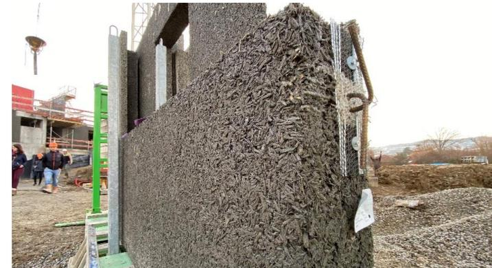
Construction d'un ensemble collectif en béton de bois (préfabrication assimilable à du hors-site).
