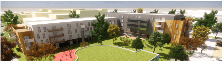
Luisant, rue Gutenberg, résidence intergénérationnelle de 60 logements collectifs
