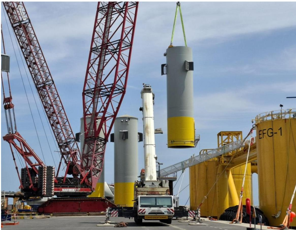
*Fin mai – Montage des sections de mât de la première éolienne sur le flotteur.*
