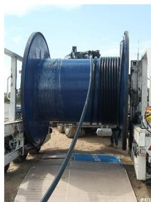
*Installation du forage dirigé et déroulage du câble de raccordement sur la partie terrestre*
