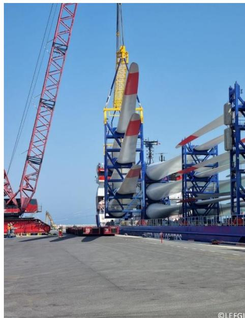
Les opérations de levage, de transport et de stockage de ces éléments éoliens ont été réalisées en étroite collaboration avec la société Euroports, Mammoët, son sous-traitant et opérateur de la grue de levage Terex Demag CC 8800-1, ainsi que les équipes de la société Vestas mobilisées sur le quai.
