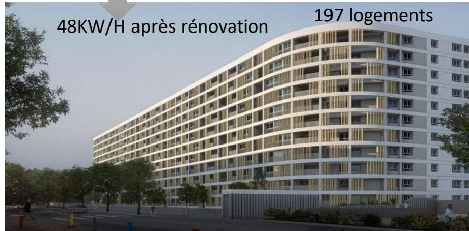
Amélioration du confort thermique d'été : La réglementation impose le nombre d'heures où le logement ne doit pas dépasser les 28°C (350h/an). Ce bâtiment est conçu pour être à 93h !
