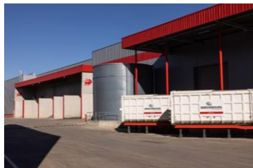
DERICHEBOURG Ligne de recyclage de ballons d'eau chaude
