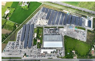
GPA 26 Usine de recyclage automobile
