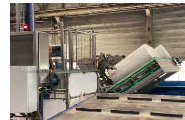
RENEWI Ligne de recyclage de ballons d'eau chaude
