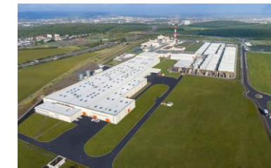
KNAUF Usine de dalles acoustiques
