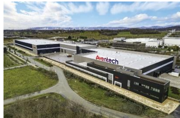
AVENTECH Usine d'équipements électriques critiques
