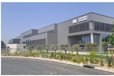
ALSTOM Usine de piles à combustible
