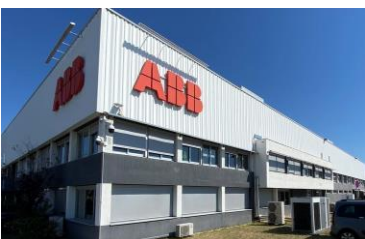
ABB Usine de contacteurs basse tension
