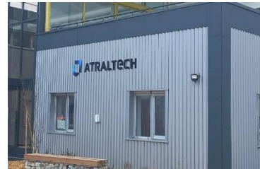
ATRALTECH Usine d'alarmes connectées
