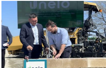
UNELO Usine de béton compacté routier bas carbone
