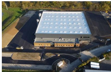
POLIECO Usine de tubes annelés double paroi
