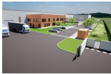
SOPREMA STEEL Usine de structures en acier
