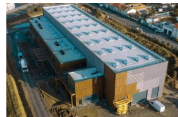
CHANTIER DE L'ARSENAL Usine de catamarans
