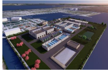
QAIR Usine de production hydrogène vert
