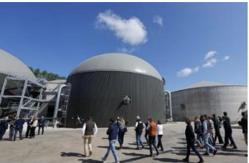
DAUDRUY Usine de gaz vert
