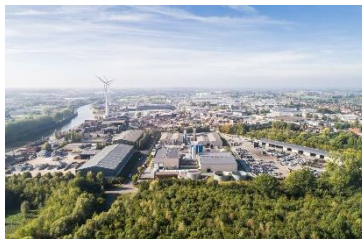
GALLOO Usine de broyage de déchets métalliques
