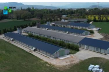
HB BAT Usine de panneaux photovoltaïques
