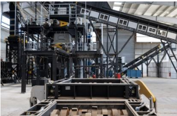
DECONS Usine de valorisation de ballons d'eau chaude
