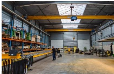
METIS LEVAGE Usine d'appareils de levage
