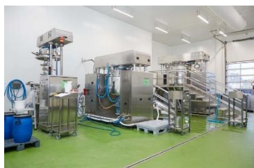
TECHNATURE Usine de cosmétiques
