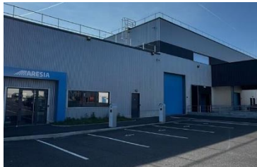
ARESIA Usine d'équipements aéronautique
