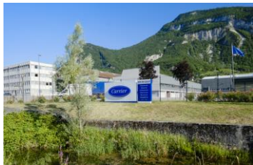
CARRIER Usine de systèmes de refroidissement pour data centers
