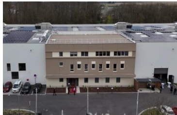
DOORTAL Usine de portes métalliques
