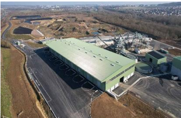
TERZEO Usine de valorisation et dépollution
