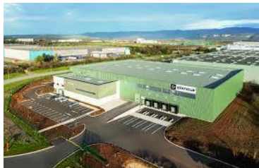
DIXNEUF Usine d'accessoires pour poêles et cheminées
