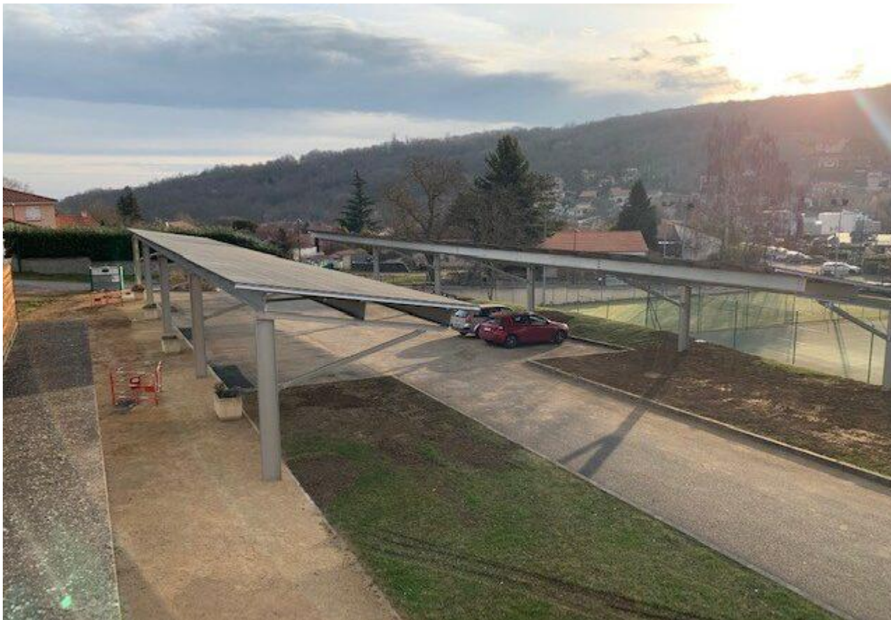
Source : Assemblia , ombrière du parking devant le gymnase de Nohanent, 2022
