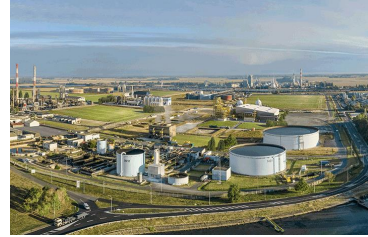
TOTAL ENERGIES Usine de recyclage chimique des plastiques complexes
