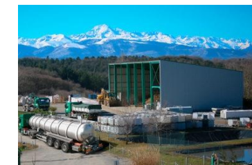
PSI ENVIRONNEMENT Usine de combustibles solides de récupération
