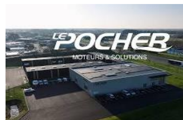
LE POCHER Usine de moteurs maritimes
