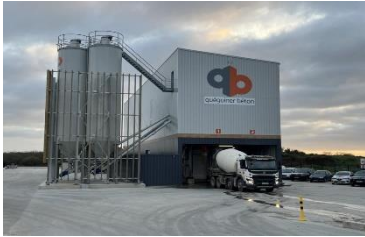
GROUPE GUÉGUINIER Usine de béton polymère
