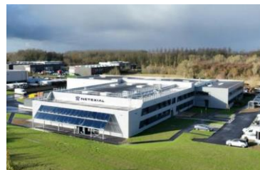
NETEXIAL Usine de blanchisserie industrielle
