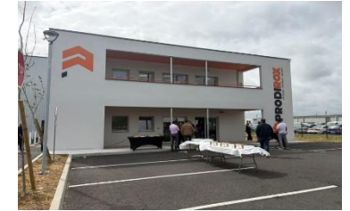
PRODIROX Usine de traitement de surfaces
