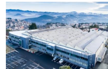
GAGNE Usine de structures métalliques
