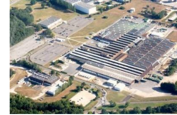
JOHN DEERE Usine de batteries électriques
