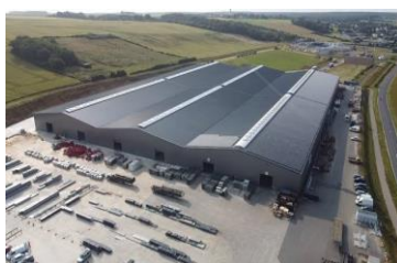
TRIANGLE ENERGIE Usine de charpentes et de panneaux photovoltaïques
