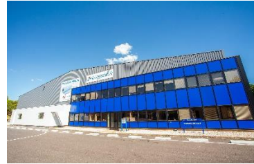
LEYGATECH Usine d'emballages plastiques
