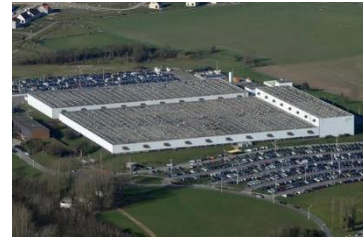
VALEO Usine d'onduleurs haute tension
