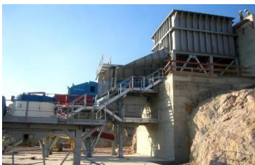
CAMARD Usine de recyclage de déchets
