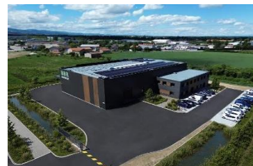
BBR ENERGIE Usine de systèmes de stockage d'énergie
