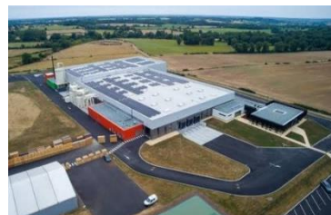
SARGAM Usine de menuiserie extérieure
