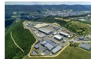
ENVIRONNEMENT MASSIF CENTRAL Usine de surtri du plastique
