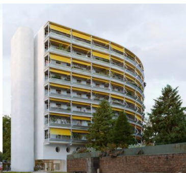
Après : façade ouest
