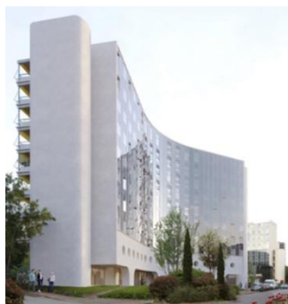
Après : façade est
