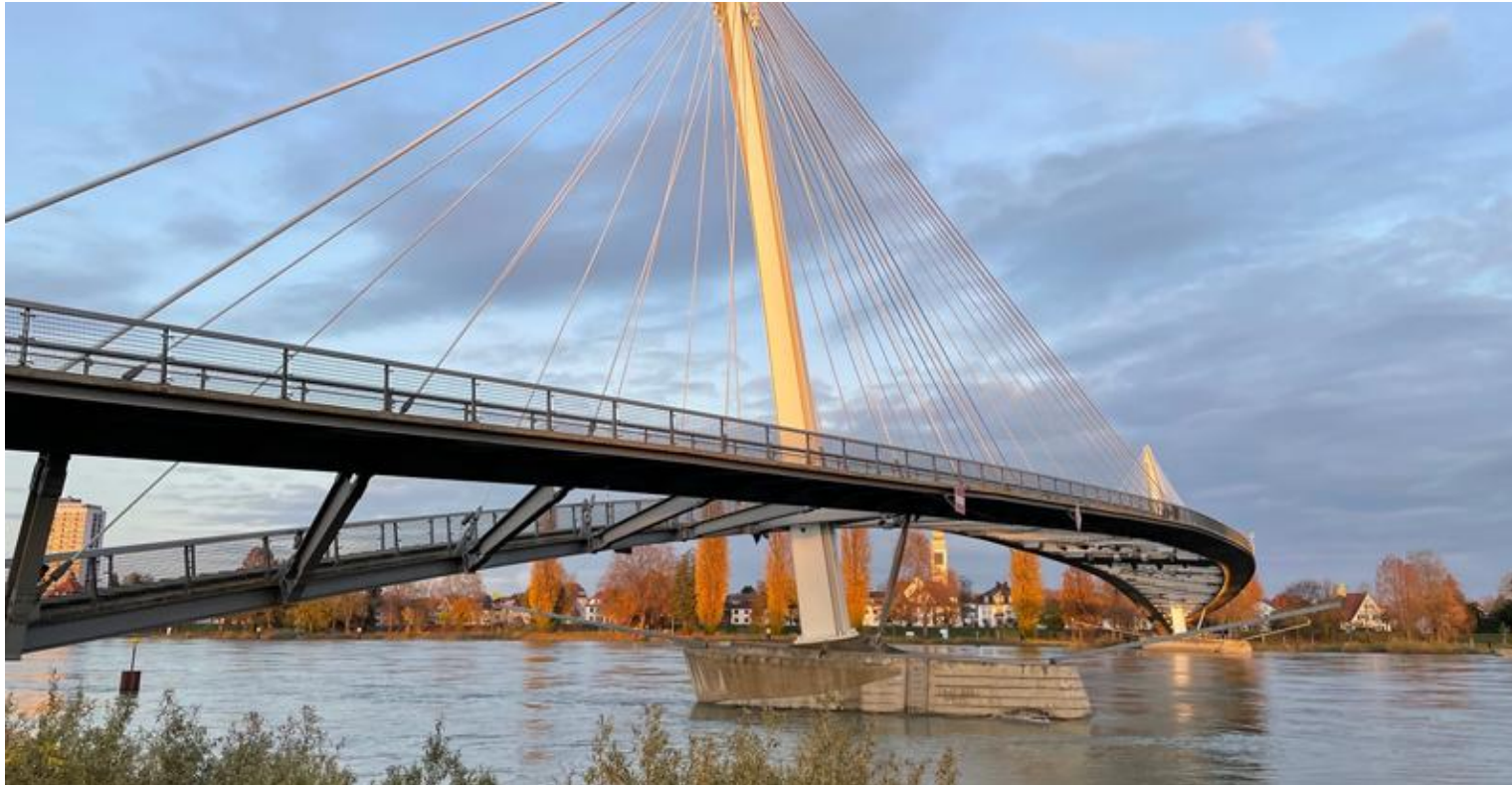
Passerelle des Deux Rives, Photo MOT
