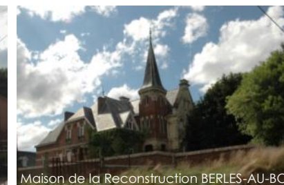
Maison de la Reconstruction BERLES-AU-BOIS
