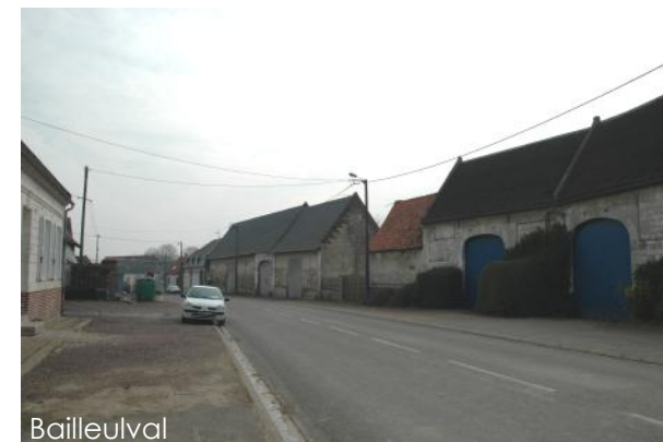
rue principale (Grand'rue) remplissant le rôle d'axe central grâce aux trottoirs de dimensions importantes
