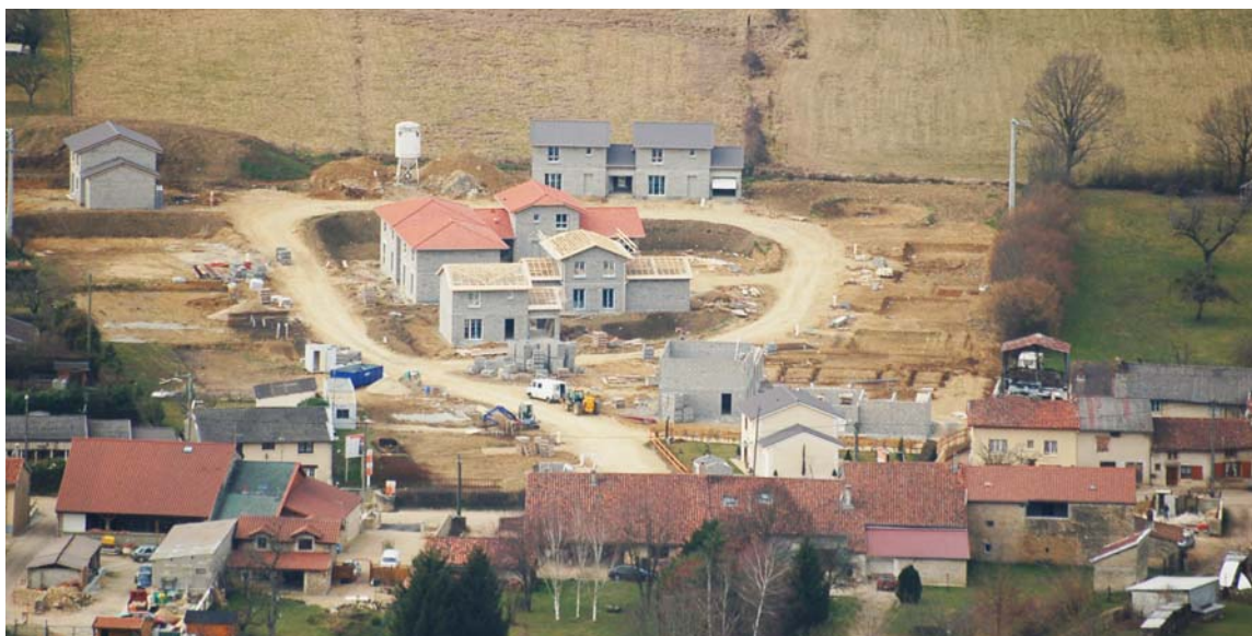
Lotissement "Les Sorbiers", hameau de Treconnas
