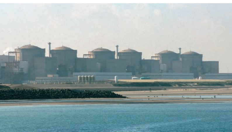
Le centre nucléaire de Gravelines.
