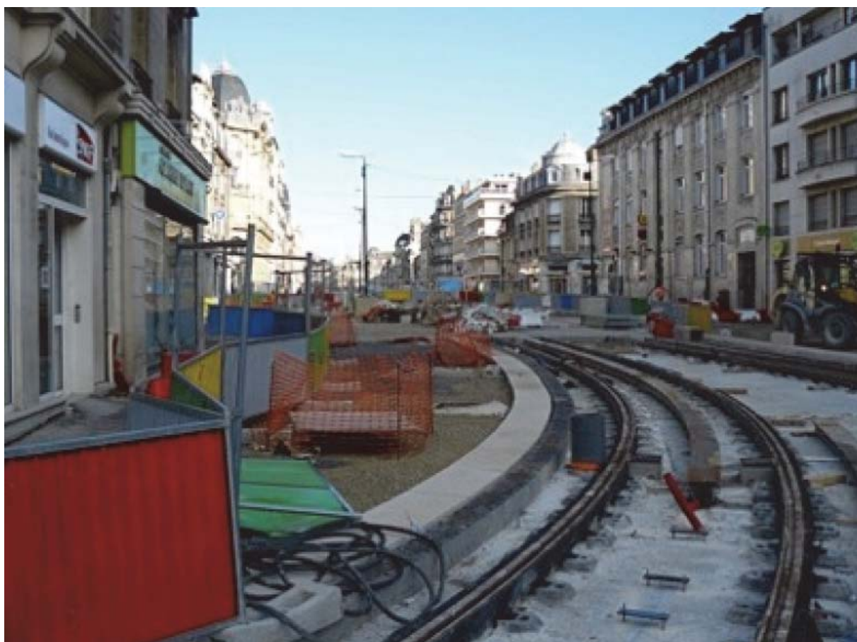
Figure n° 17. Le chantier d'aménagement du tramway, dans le centre-ville de Reims
