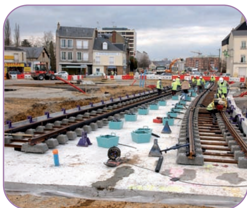
Travaux du Citadis, Le Mans
