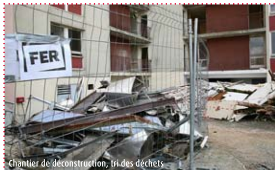
Chantier de déconstruction, tri des déchets
