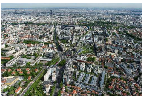
Réaménagement de la RD 920 entre Bourg-La-Reine (CD92), Cachan, Arcueil (CD94) et Paris
