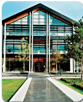
Soissons, Les Ambassadeurs Pépinière d'entreprise ©Wilmotte & Associés
