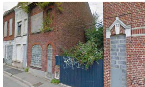
Rue Lannes, à Roubaix. Source : dossier de candidature de la Ville de Roubaix à l'AMI.
