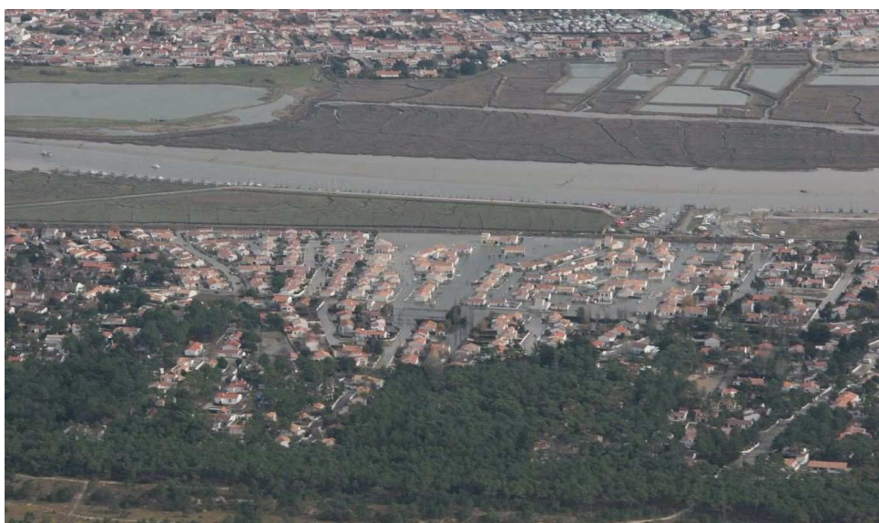
La Faute-sur-mer (85) après le passage de la tempête Xynthia - 28 février 2010
